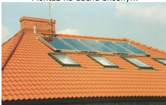
Montaż na dachu skośnym
